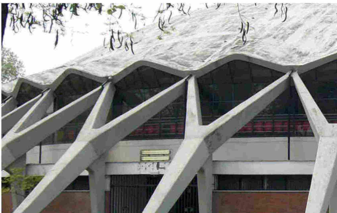
Particolare dei cavalletti di sostegno del Palazzetto dello Sport a Roma, opera di Pierluigi Nervi. Foto di Blackcat - Opera propria, CC BY-SA 3.0, https://it.wikipedia.org/w/index.php?curid=4126377
