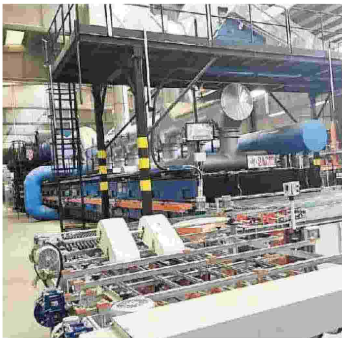
Nuovi impianti all'interno dello stabilimento di Ita Ceramiche
